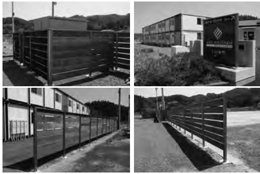
これまでの施工事例 震災復興住宅での事例
